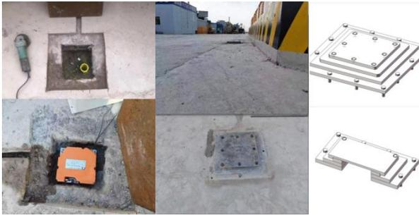
自动提升式测斜仪保护装置
